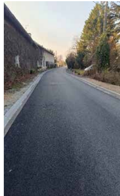
Rue du Chemin Vieux, pose des bordures de trottoir
