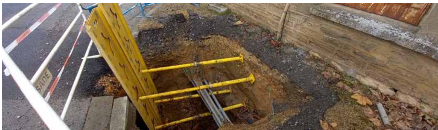
Branchement en traditionnel avec pose d'une boîte au niveau du croisement rue du Palachin RD 933
